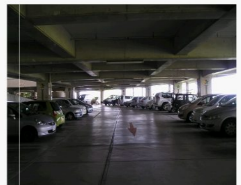
⑬ 運動公園立体駐車場
