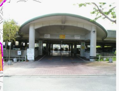
⑫ 運動公園立体駐車場入口
